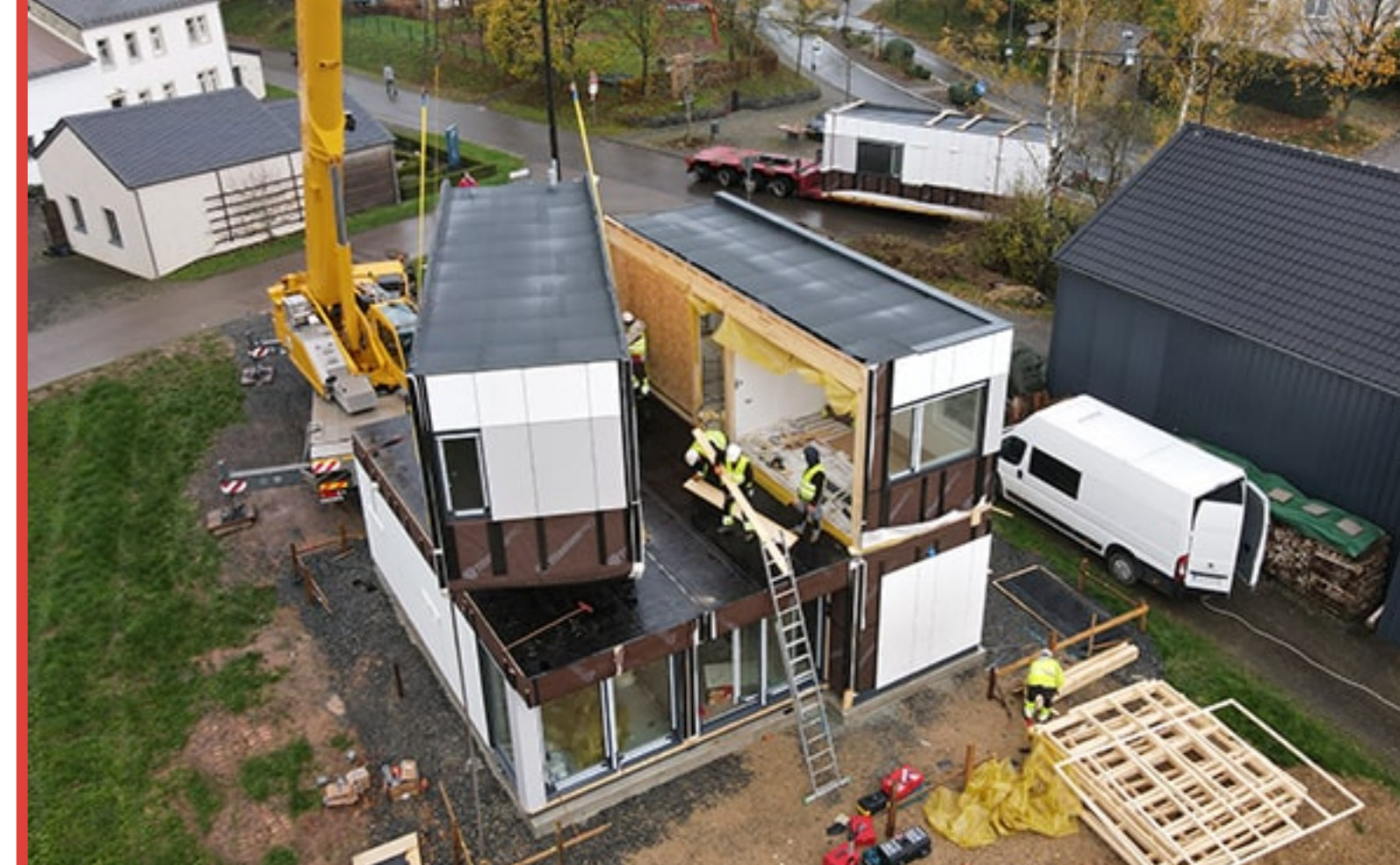
Montaż domu wykonanego z 6 modułów
