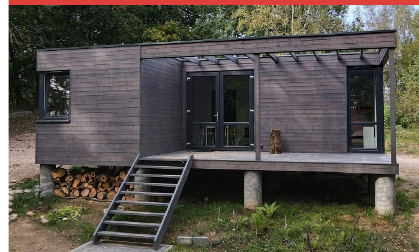
Apartament 35L z elewacją z deski pióro-wpust
