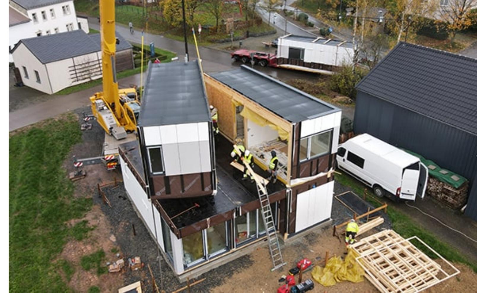
Montaż domu wykonanego z 6 modułów
