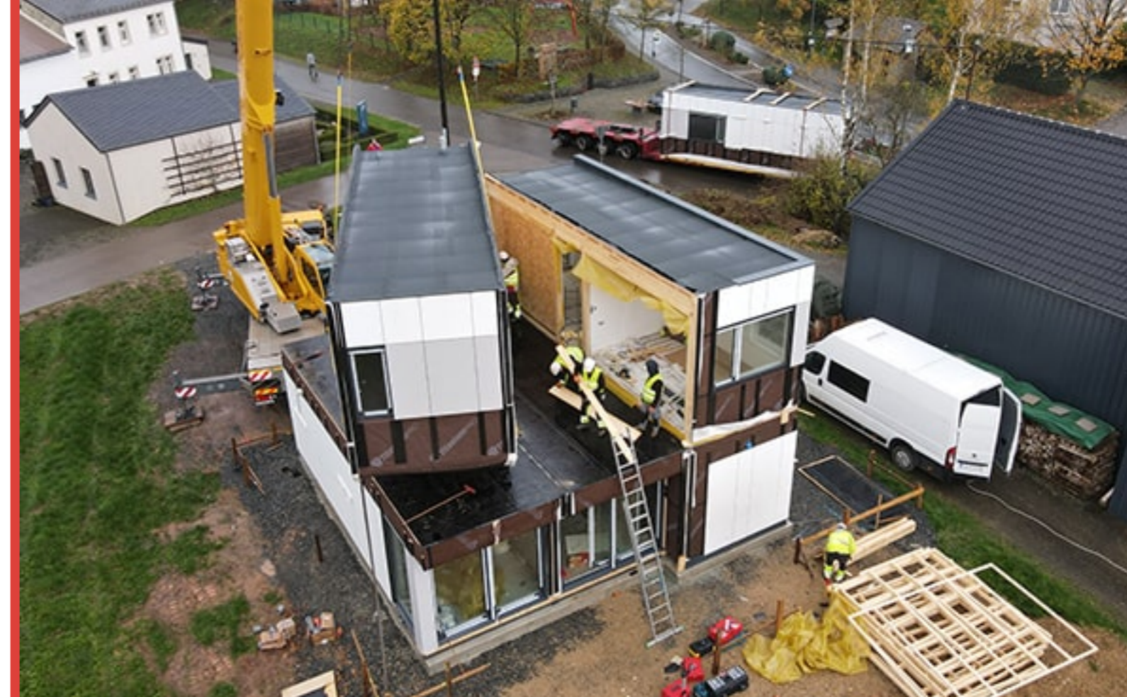
Montaż domu wykonanego z 6 modułów
