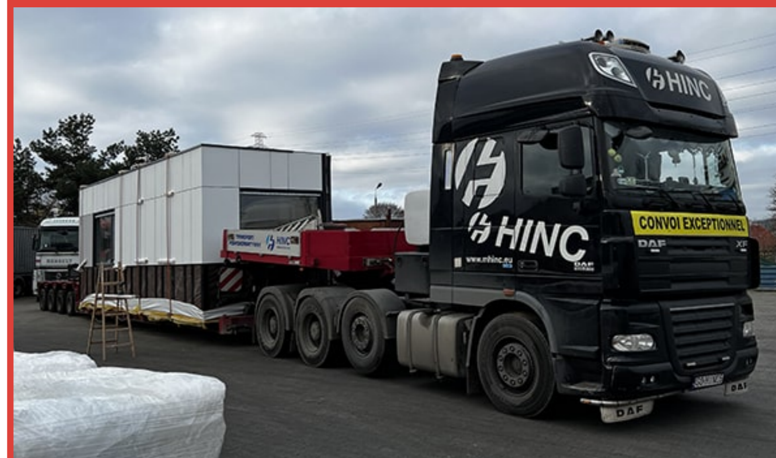
Transport domu modułowego na działkę
